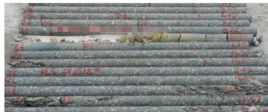
图 C.1.3-4 1518#桩芯样夹泥、蜂窝、沟槽
