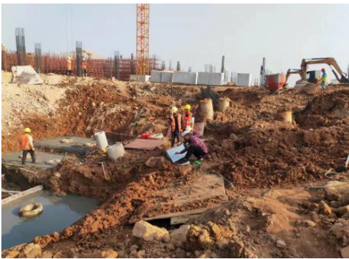
(b) 开挖后淤泥未裸露
