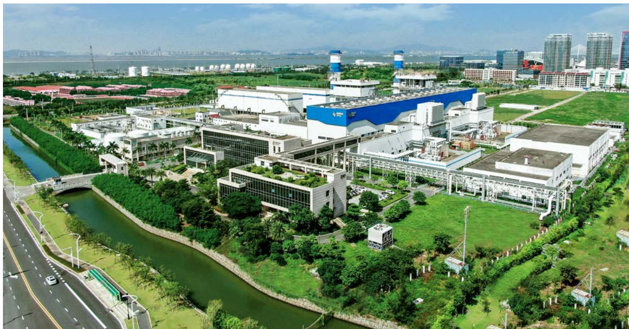
横琴能源设施建设
