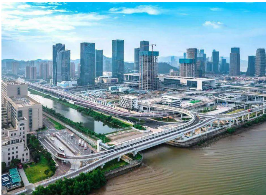
澳门大学连接横琴口岸通道桥项目
