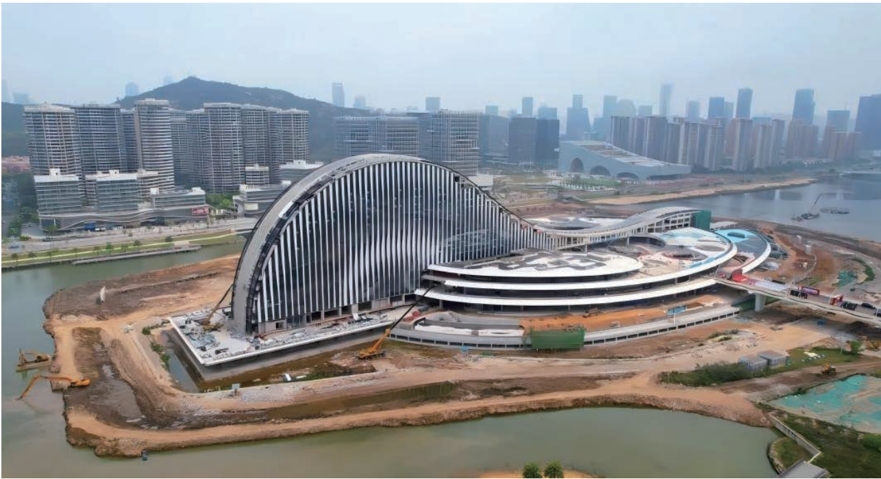
天沐琴台（建设中）
