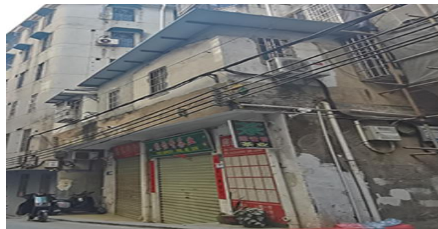
图 3 屋面加建砌体结构采用轻钢屋盖
