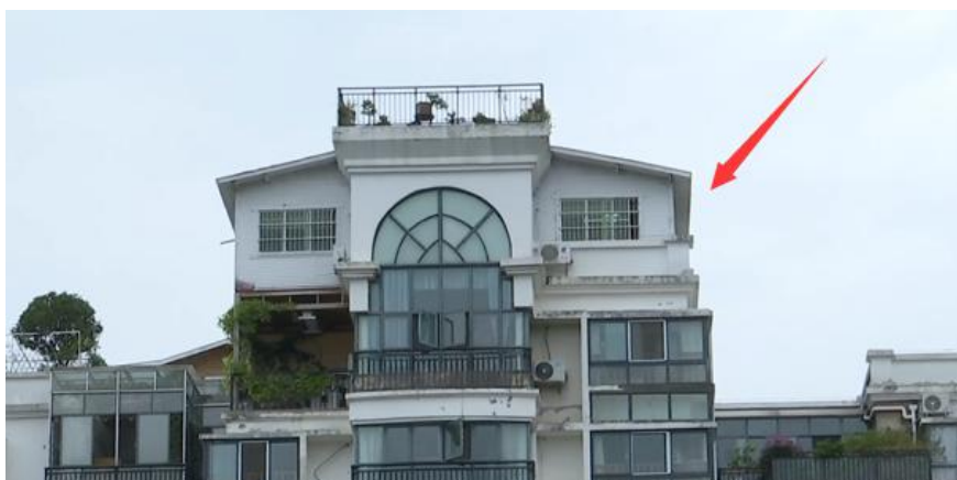
图 5 屋面加建 1 层混凝土框架结构
