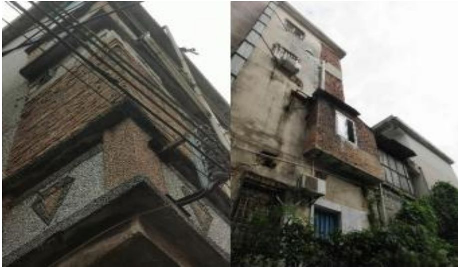
图 11 悬挑梁、悬挑板上增加墙体
