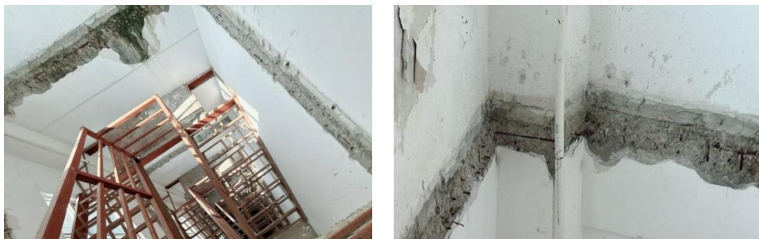
图 16 拆改主体结构
