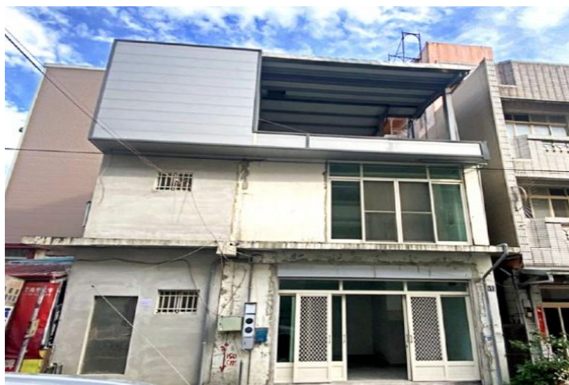
图 6 屋面加建两层房屋
