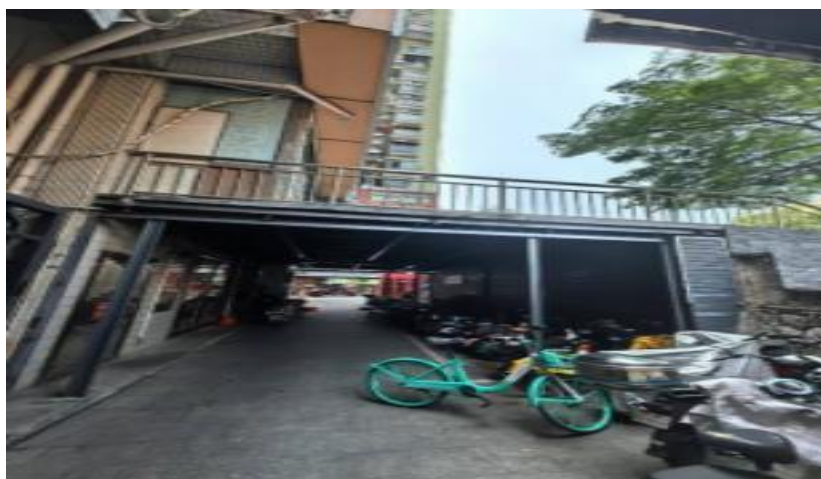
图 15 房屋与周边挡土墙间扩建连廊
