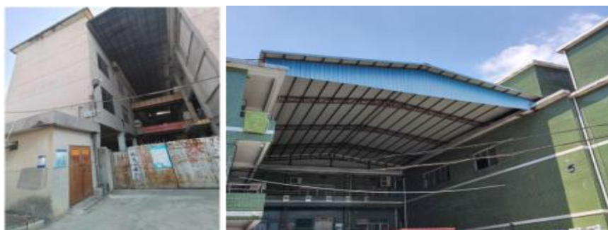
图 13 相邻建筑物之间扩建轻钢结构屋盖
