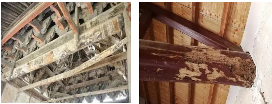
图 21 木构件存在变形、虫蛀
