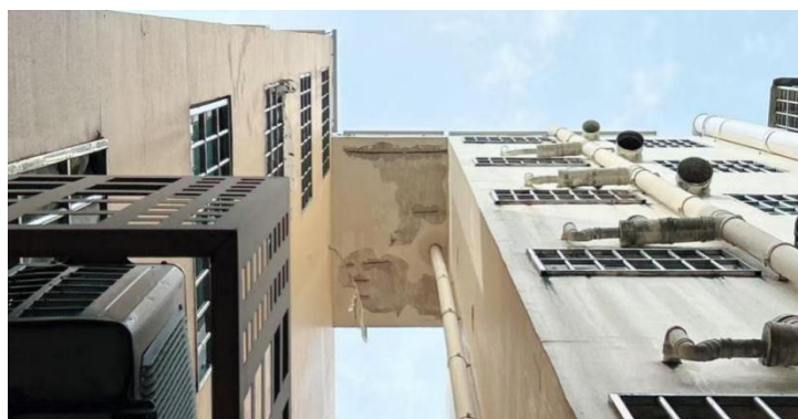
图 14 相邻建筑物之间扩建连廊
