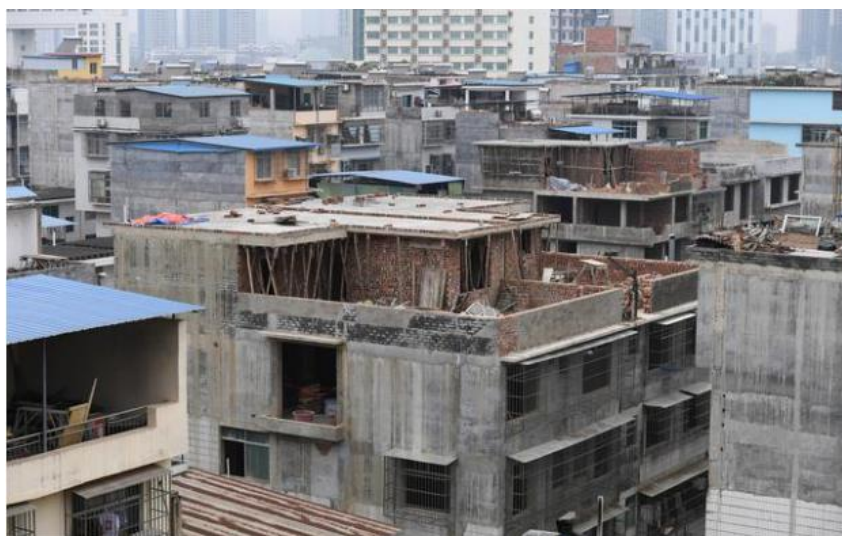
图 4 屋面加建 1 层砌体结构
