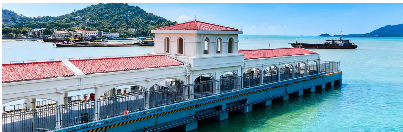
横琴码头改扩建工程项目
