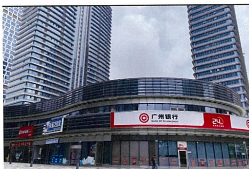
中交汇通横琴广场外观
