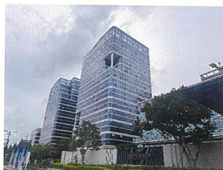
永同昌时代广场（未来中心）外观
