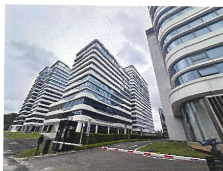
云谷广场一期、二期外观
