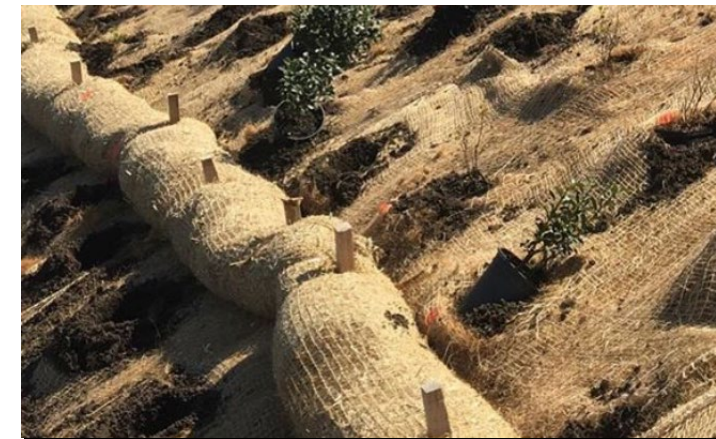
Step 2: 细网黄麻织物固土满铺 直径 0.3m 黄麻卷长钉固定 @5m 预留树穴，乔木种植
