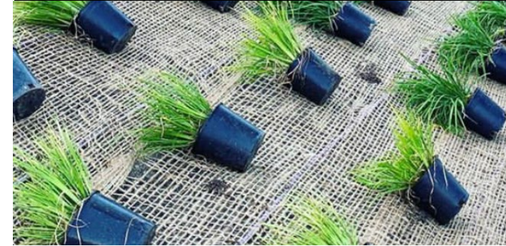
Step 3: 二次覆土 + 复绿喷播 粗网黄麻织物固土满铺，灌木种植
