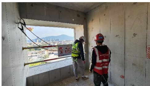
扣挂安全带、拆卸围栏
