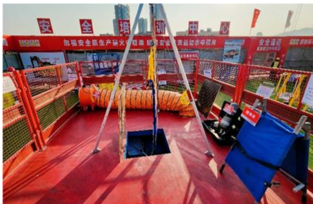
应急措施、安全应急物资(救援三脚架、担架床、急救箱)、对讲机、空气压缩瓶及面罩、防爆灯、全身式安全带、看守员
