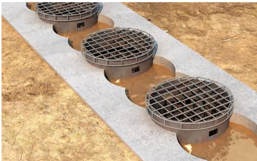
桩孔防护示意图
