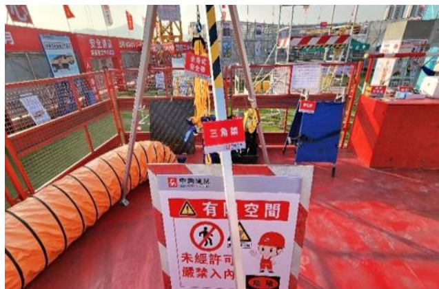
应急措施、安全应急物资(救援三脚架、担架床、急救箱)、对讲机、空气压缩瓶及面罩、防爆灯、全身式安全带、看守员
