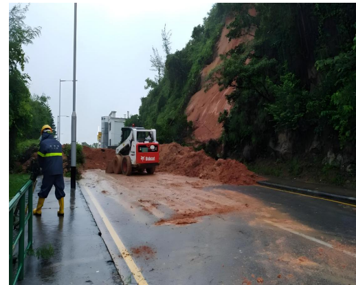
施工现场交通受阻
