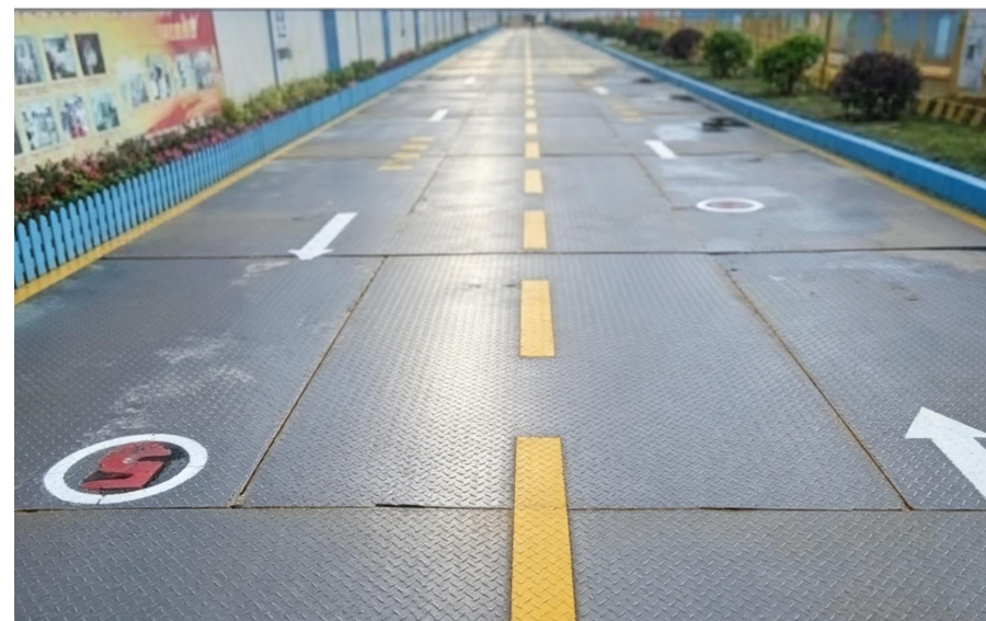
钢板硬底化道路
