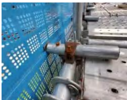
冲孔板连接件形式一
