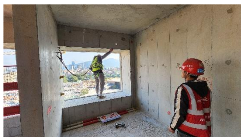
施工过程中旁站监督
