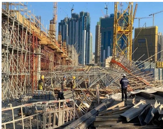
脚手架倒塌
