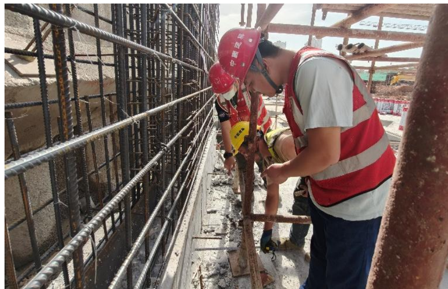
排架前，离墙间距300mm测量
