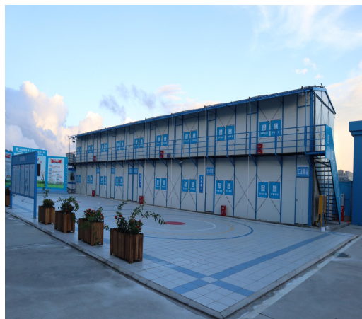
临建设施防台加固
