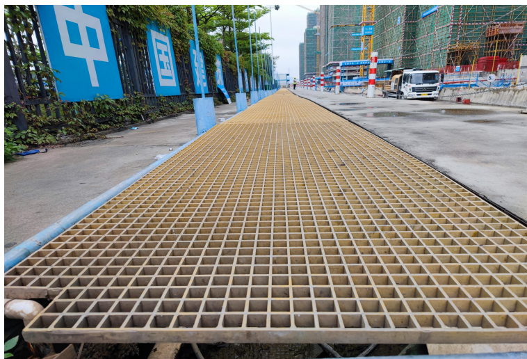
排水沟及篦子罩面
